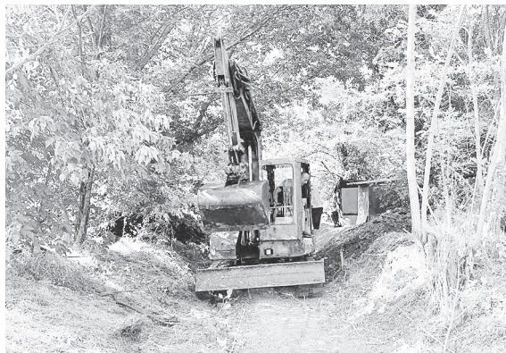
● Прочистка дренажной канавы в ст. Грушевской.
